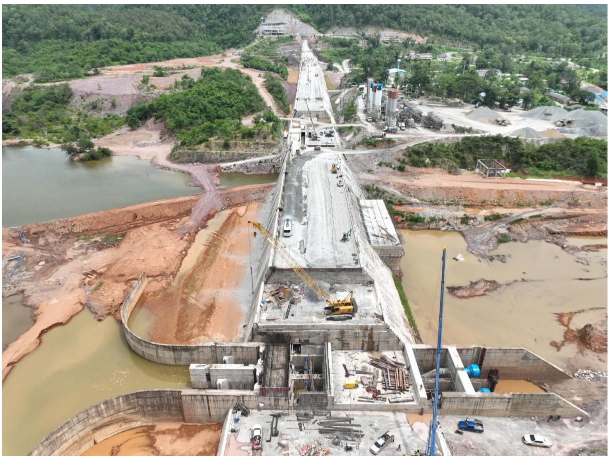
รูปที่ 1.9-2 งานก่อสร้างตัวเขื่อนคอนกรีตบดอัด
